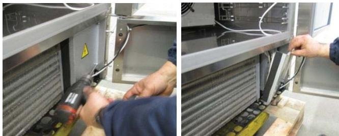
Удалить фиксирующие винты электрического щита.
